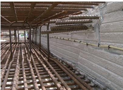
SikaFuko® 주입 호스 시스템은 콘크리트 타설 전에 설치되며 콘크리트 경화 후 바로 사용할 수 있습니다. 누수가 발생할 경우 방수 콘크리트 구조물의 대부분의 영역에 직접 빠르게 접근할 수 있습니다.
