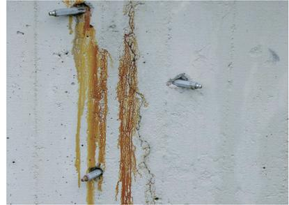
충진재는 구조물을 밀봉하는 데 사용될 뿐만 아니라 콘크리트 구조물의 구조적 무결성을 개선하거나 복구하는 데에도 사용될 수 있습니다. 움직임이 없는 균열과 비균질 영역은 경질 소재로 접합, 충전 및 밀봉할 수 있습니다.
