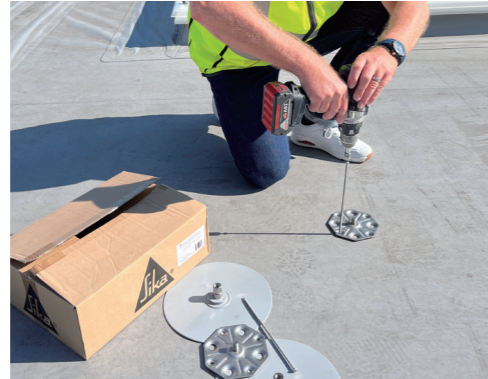
Washer 110 KR 앵커 시스템 현장 적용 사례 (Anchor Application Examples)
