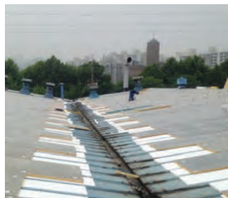
2. 우레탄 보드 설치
