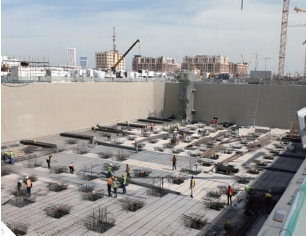
1 Sikaproof® 808 완전 접착 기술을 사용하는 유연한 TPO 시트 멤브레인
