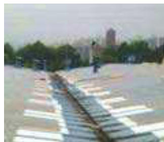
2. 우레탄 보드 설치
